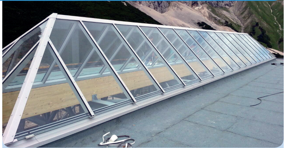
Bei der Issentalkopf-Sesselliftstation vertraute man auf das Satteloberlicht aus Echtglas der Serie TENTOLUX PLUS.
